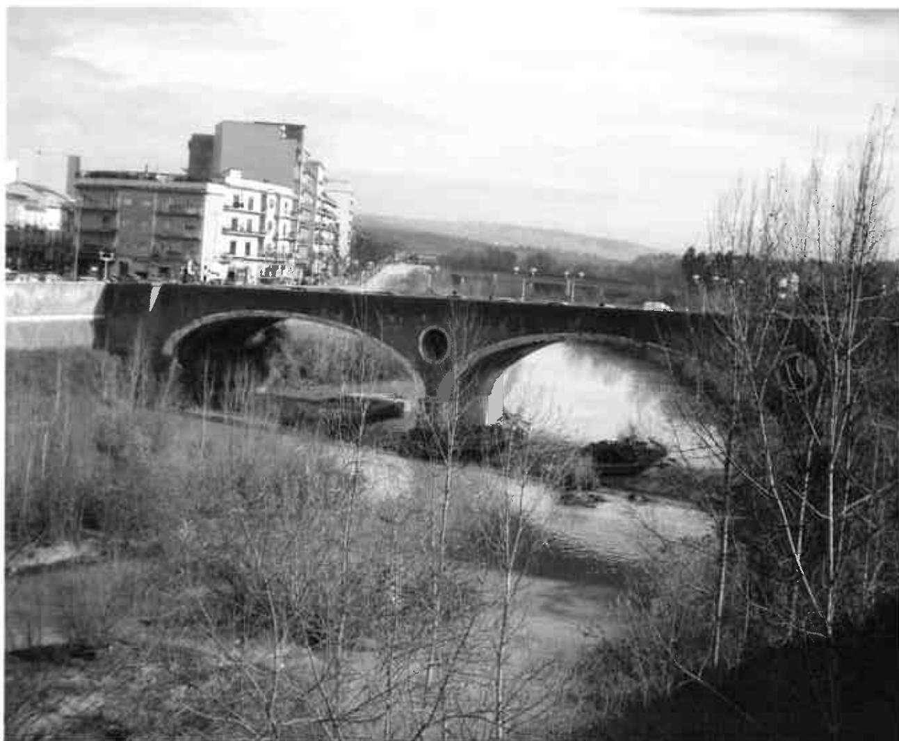
Fiume Calore – nei pressi del Ponte Vanvitelli a Benevento.
